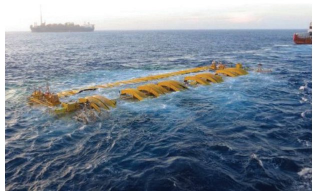
Submersão da BSR Sul em Lula NE
