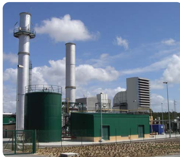
Central de Cogeração do Carriço
